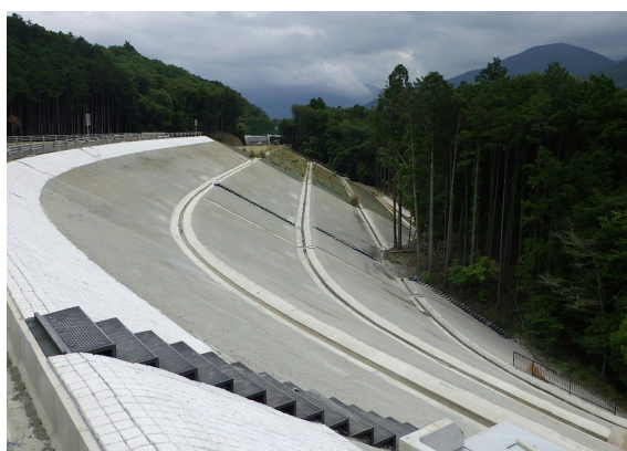
道路工事 盛土法面の防草工【本設タイプ】
