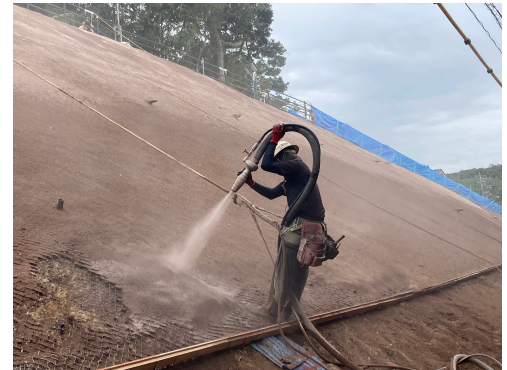
切土法面吹付
