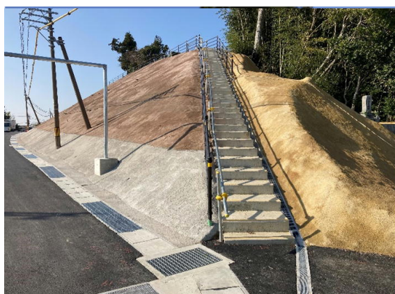
道路工事 切土法面の防草工【本設タイプ】
