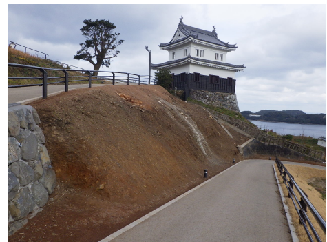
法面清掃完了
