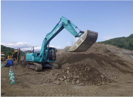
専用除礫バケットによる篩い分け
