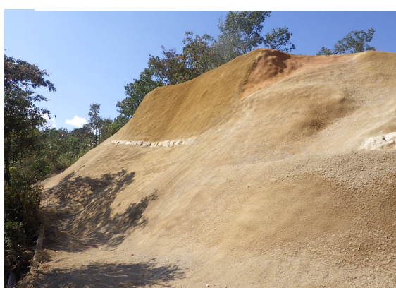
史跡整備工事 土系吹付による成形仕上【本設タイプ】
