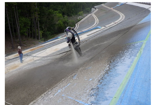
盛土法面吹付
