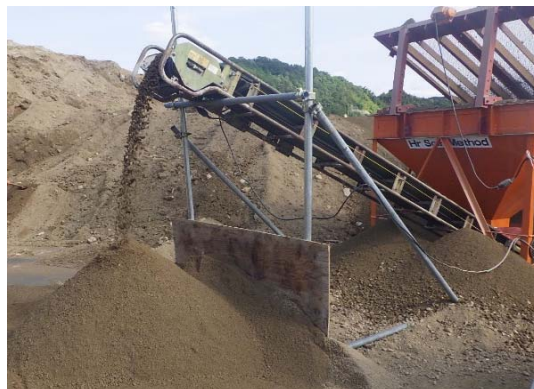
吹付用土砂 粒径処理完了
