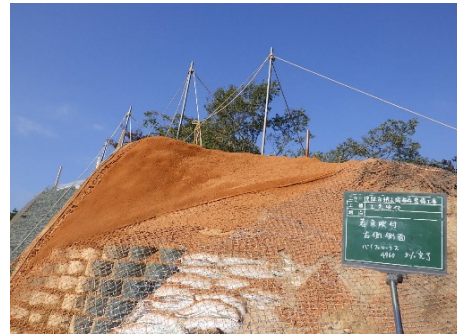
着色吹付完了(バイフェロックス4960)
