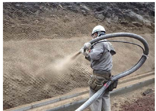
乾式吹付作業
