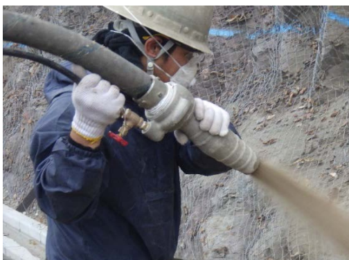
乾式吹付ノズル
