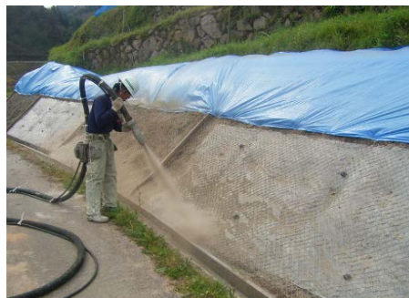
上部シート張り
