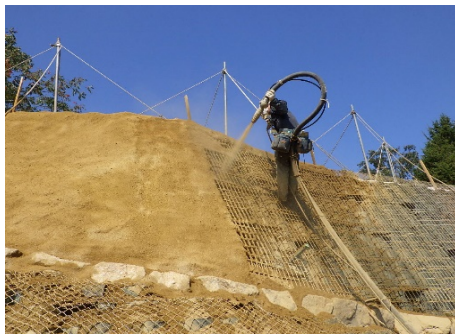
着色吹付状況(バイフェロックス4920)
