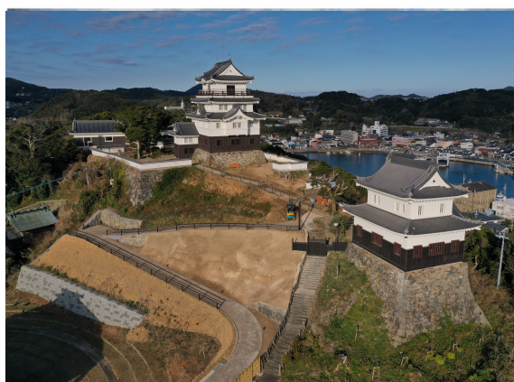
公園工事 自然斜面の防草工【本設タイプ】
