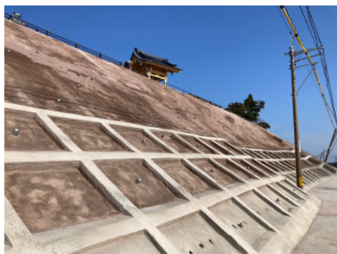
切土法面 防草土吹付 完成
