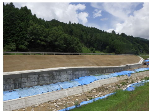
盛土法面 防草土吹付 完成
