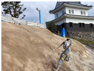
乾式吹付作業と仕上がり状況
