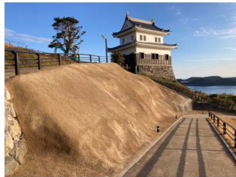
自然斜面 防草土吹付 完成
