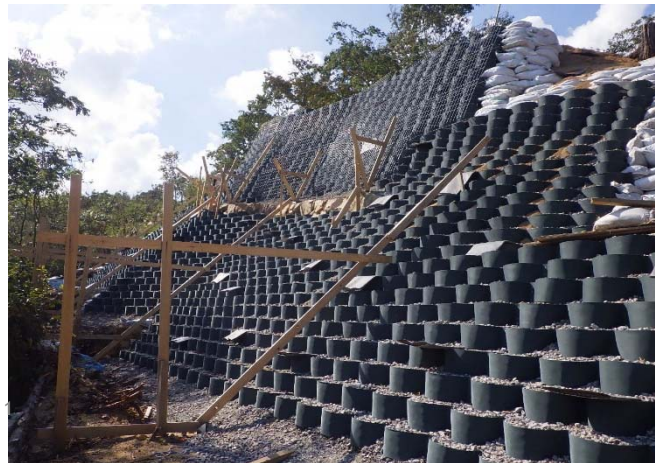
ジオセルによる史跡保護及び復元成型
