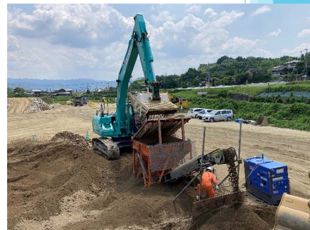
振動篩付き土砂ホッパーによる2次篩
