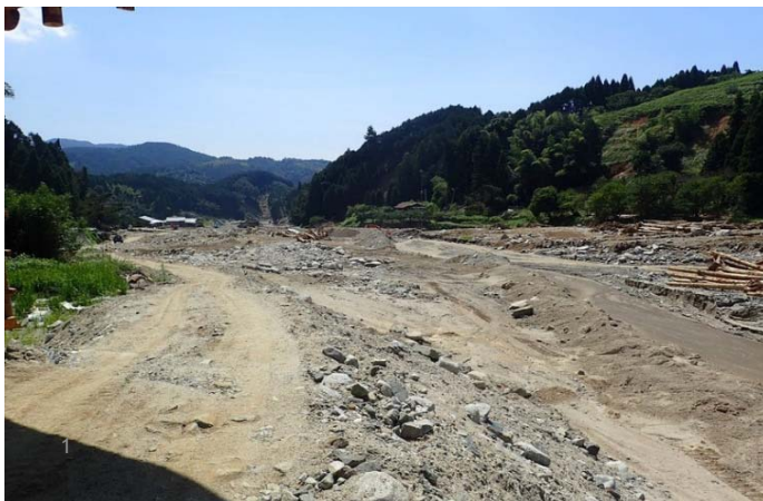
平成29年 九州北部豪雨により被災
