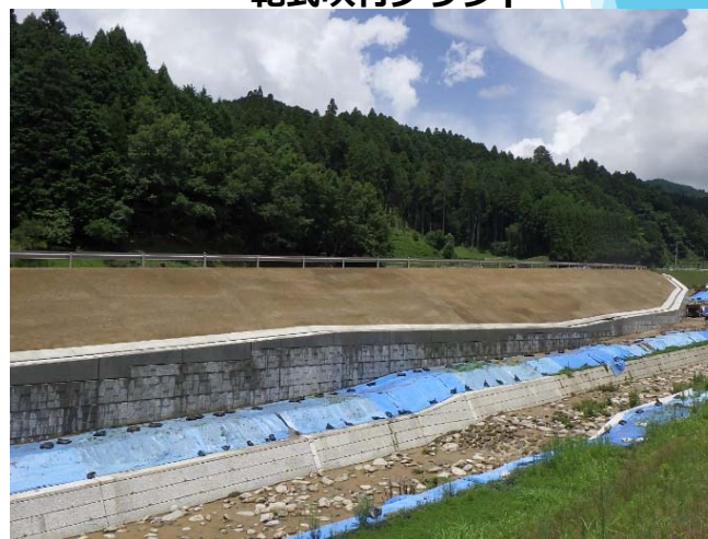
盛土法面吹付完了
