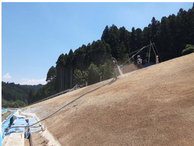
乾式吹付作業
